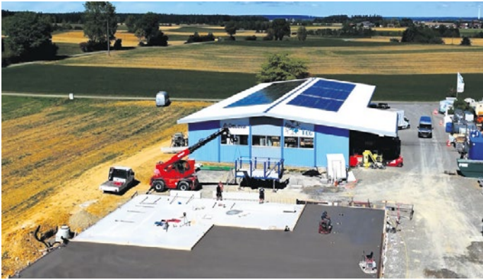
Hier eine Luftaufnahme der entstehenden neuen Halle COOL-BASE. Am Samstag, 10. Oktober, ist Richtfest.
