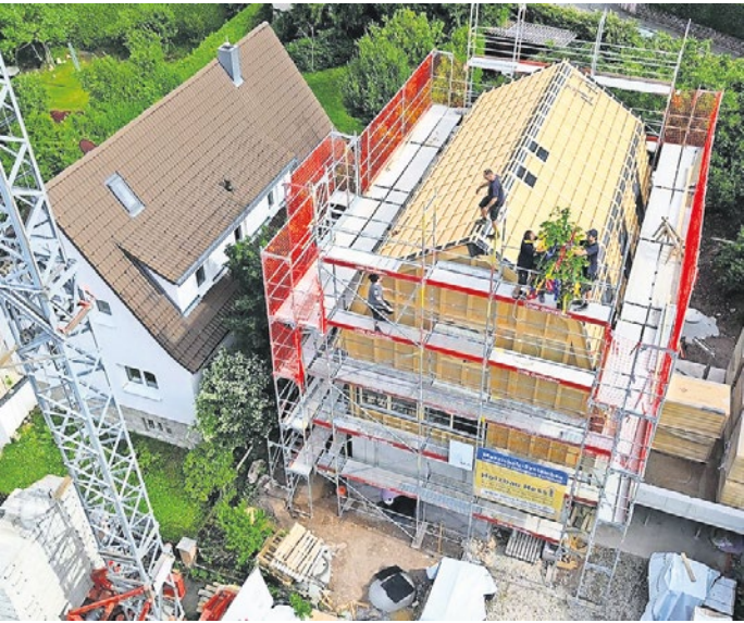
Richtfest. Ein wichtiger Teil des Bauprojekts ist geschafft. Foto: Hess
